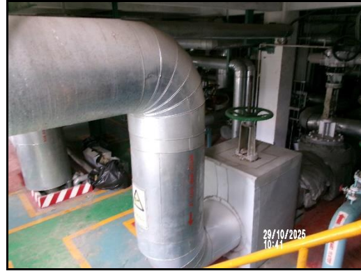
ภาพที่ 2.21 ผนวกกันความร้อนเครื่องจักรบริเวณโครงการ WHG
