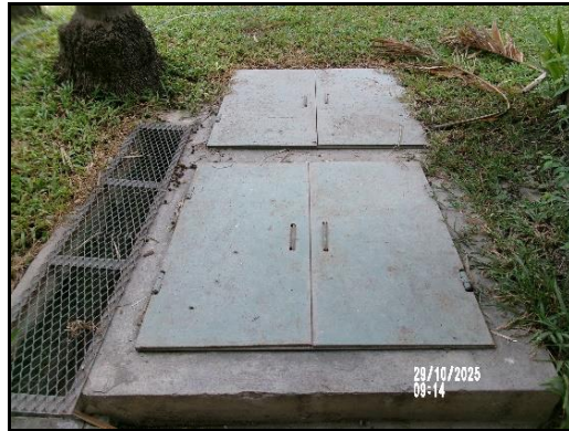
ภาพที่ 2.9 บ่อเกรอะ-บ่อซึม สำหรับบำบัดน้ำทิ้งจากสำนักงาน
