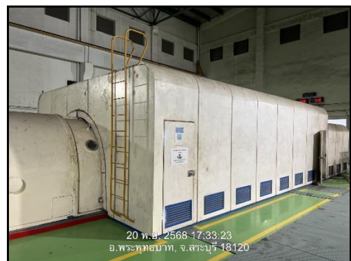
ภาพที่ 2.12 อุปกรณ์ครอบแหล่งกำเนิดที่ก่อให้เกิดเสียงดัง
