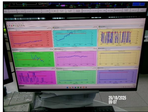
ภาพที่ 2.2 จอแสดงผลการติดตั้งเครื่องตรวจวัดฝุ่นที่ระบายออกจากปล่องหม้อเผา (CEMs) เพื่อการควบคุมปริมาณฝุ่นให้อยู่ในเกณฑ์ที่กำหนด ภายในห้องควบคุมการผลิต
