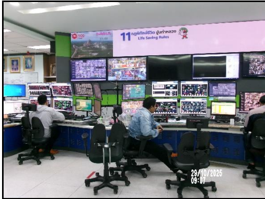
ภาพที่ 2.1 กล้องวงจรปิดเพื่อสังเกตความเข้มข้นของฝุ่นจาก ปลายปล่องหม้อเผาภายในห้องควบคุมการผลิต
